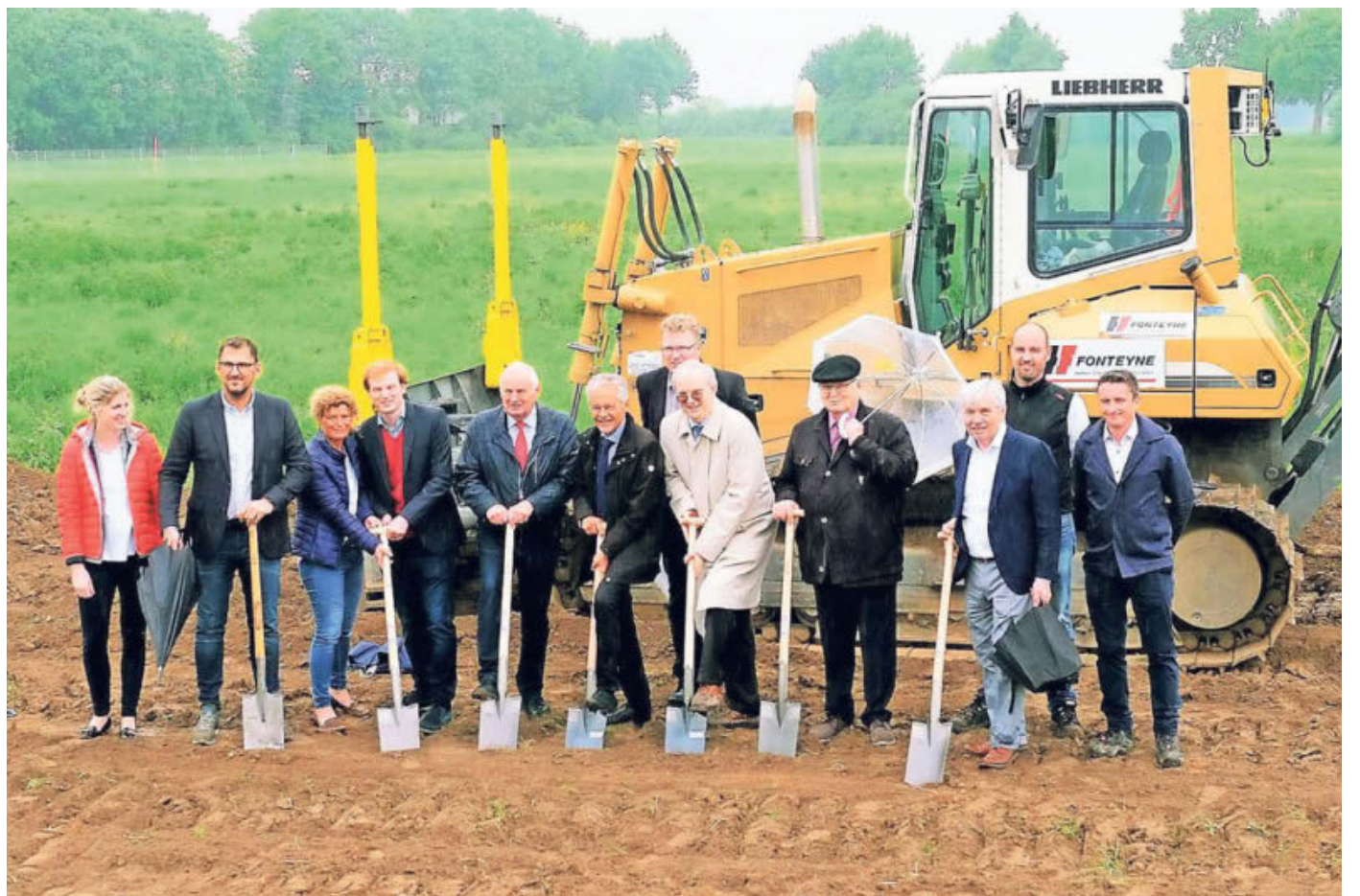
Selbst sieben Spaten reichten nicht beim symbolischen ersten Spatenstich für die neue Firmenzentrale von Hefe van Haag in Kempfen. Denn es hatten sich mehrere Generationen des alten St. Töniser Familienunternehmens am Standort Schauhütte eingefunden. Auch Kempens Bürgermeister Volker Rübo und Wirtschaftsförderer Heinz-Peter Teneyken waren dabei. Foto: Friedhelm Reimann
